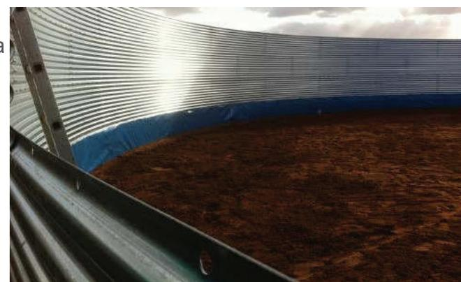
Vérifiez que l'installation a été faite de façon égale et assurez-vous de l'absence de protubérances qui pourraient endommager le liner, placez enfin le liner emballé au centre de la dalle du réservoir.
