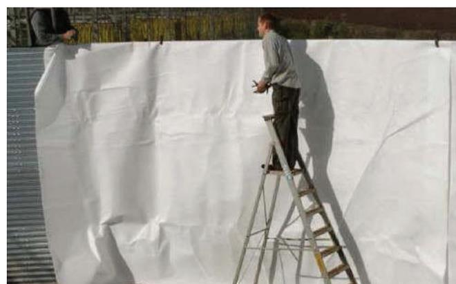
B. Bandes de polyéthylène des parois jusque la dalle, et couche de sable 50mm « sans pierre » appliqué au fond et le long des parois. Note. A la fin du montage des tôles, on peut mettre les fixations de remplacement dans les trous redondants de base.
