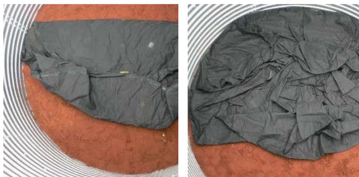
**Etape 3.** Montez progressivement les côtés du liner pour qu'ils soient dans la position parfaitement verticale (non pas tordus ou inclinés). Pour cela, le personnel à l'intérieur du réservoir doit passer les extrémités du liner à une personne se trouvant sur l'échelle à l'extérieur du réservoir.
