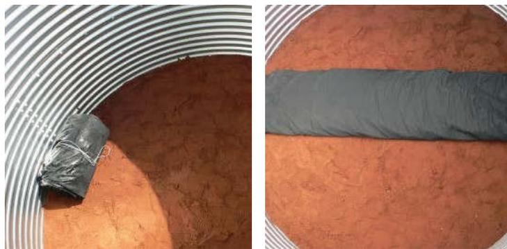
**Etape 2.** Déballez et roulez le liner au centre sur la dalle matelassée. Les bords non déployés du liner doivent atteindre la base des parois opposées. Dépliez le reste de liner, en déployant soigneusement son fond circulaire sur la dalle pour qu'il touche partout la base de la structure du réservoir acier. A la fin de cette étape les côtés du liner seront à plat sur son fond.
