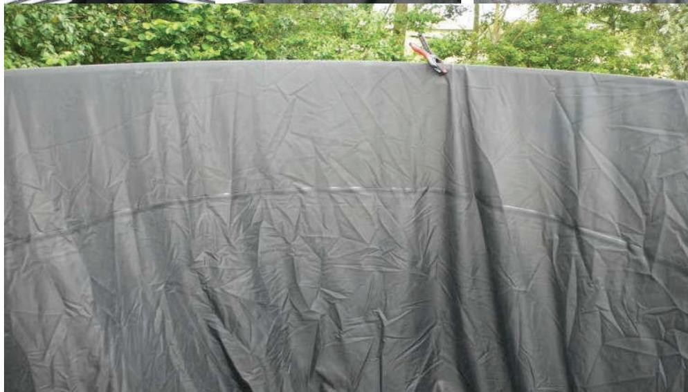
Une fois que le liner de manière régulière, vérifier encore une fois si la retombée est uniforme sur tous les côtés extérieurs du réservoir. Le personnel à l'intérieur du réservoir doit vérifier si les points de couture du liner sont parfaitement verticaux sur les parois, si le fond du liner épouse parfaitement la forme circulaire au sol, si tous les plis restants sont dépliés et ajuster si nécessaire.
