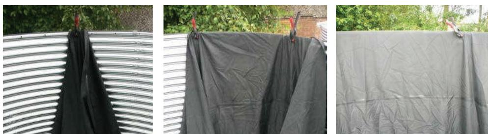
Les côtés du liner doivent retomber de la façon uniforme d'environ 12-16 pieds (30-40 cm) à l'extérieur du réservoir. Des pinces ou la bande adhésive aideront au maintien du mur au fur et à mesure de l'avancement.
