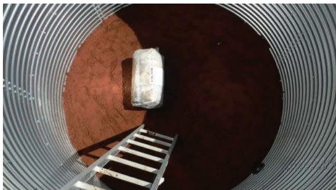
C. Feutre drainant de protection géotextile appliqué contre les parois du réservoir.
